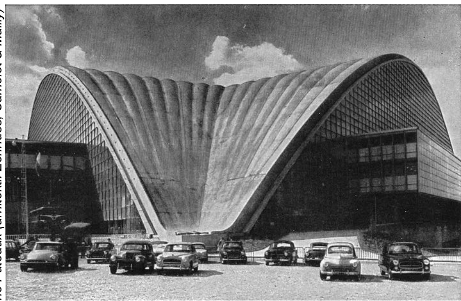
Palais du CNIT, 1958., Hauts de Seine Puteaux (arhitekti: Zehruss, Camelot & Mailly)
