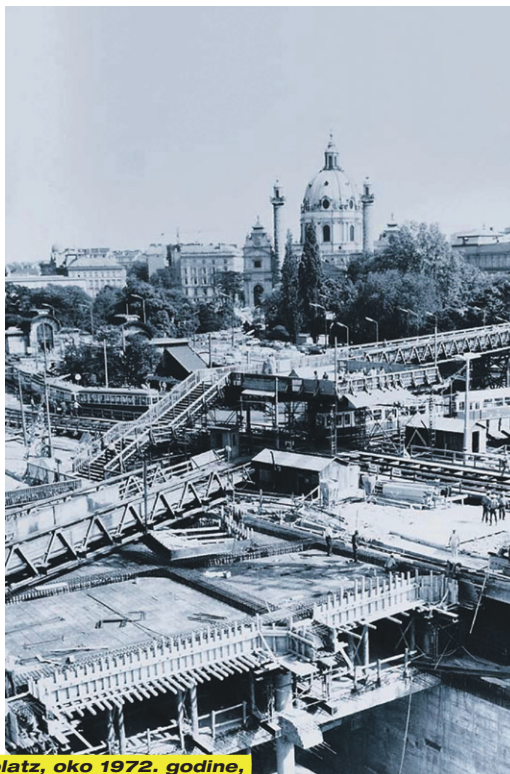
Chaosplatz, oko 1972. godine, izgradnja podzemne stanice
